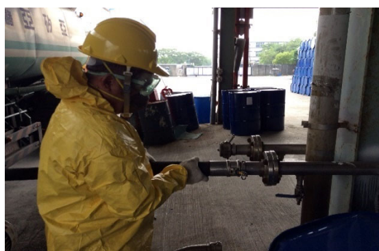
確認槽車是否有接妥接地線
