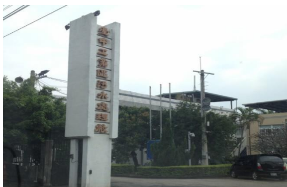
台中工業區污水處理廠
