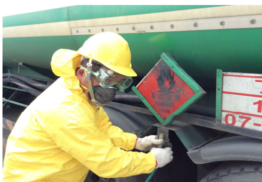
確認槽車是否有接妥接地線
